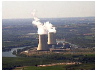
Centrale nucléaire de Golfech (Tarn et Garonne)
