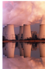
Centrale au charbon (Belgique)
