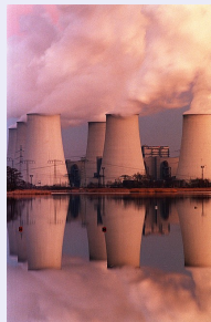
Centrale au charbon (Belgique)
