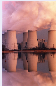
Centrale au charbon (Belgique)
